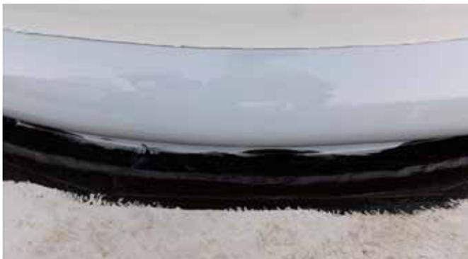
Malgré le Tec7 sur le sol, nous avons eu une infiltration d'eau, la solution fut de mettre du caoutchouc liquide de la marque HBS200 au pinceau, une couche de géotextile HBS200 et à nouveau une couche de caoutchouc liquide.
